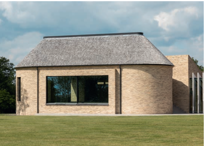
Radius på den afrundede bygning er så stor, at den kunne opmures udelukkende i standardsten.
