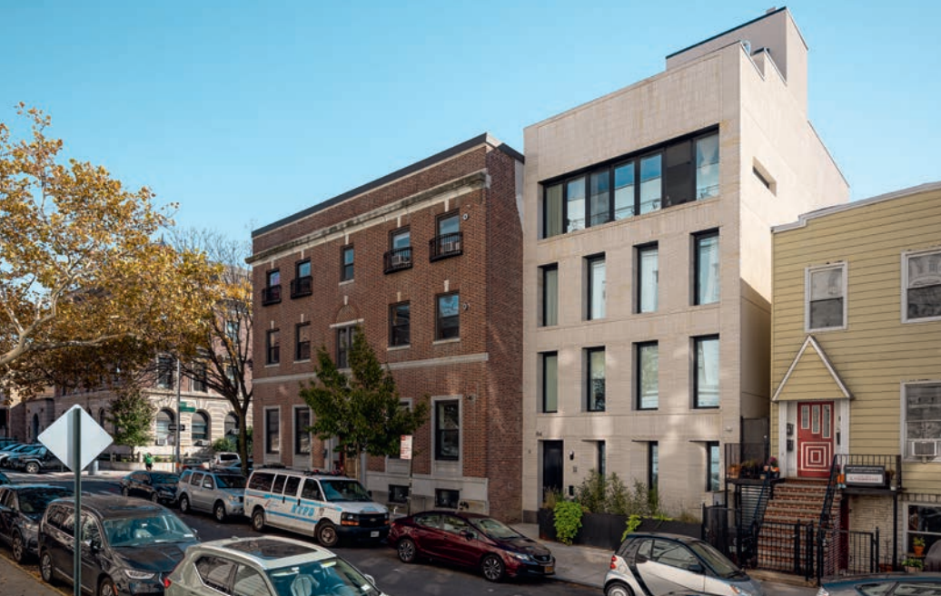
Facaden på 84 Meserole anvender K11 i et horisontalt forbandt mellem vinduerne, mens et standerskifte i de tilbagetrukne paneler markerer bygningens etageadskillelser.
