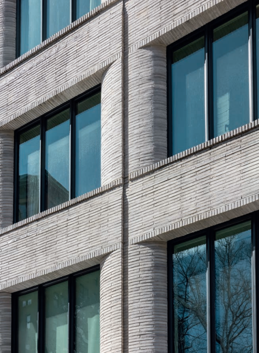
Vinduespartiernes sølbænke og overliggere er udført som rulleskifter. Foto: Dean Kaufman
