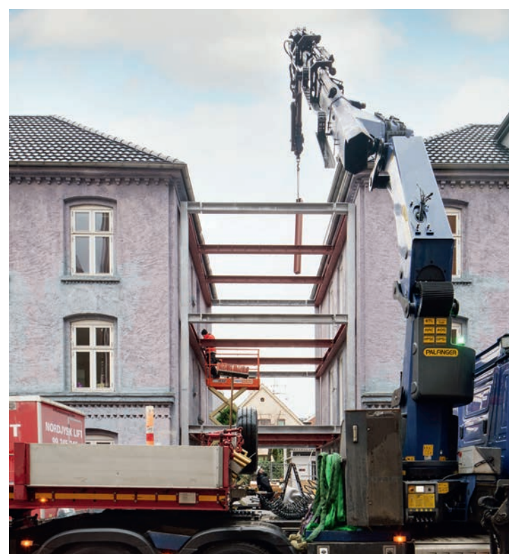
En stålrammekonstruktion lavet af genbrugsstål udgør den konstruktive kerne i tilbygningen. Foto: Morten Aagaard.
