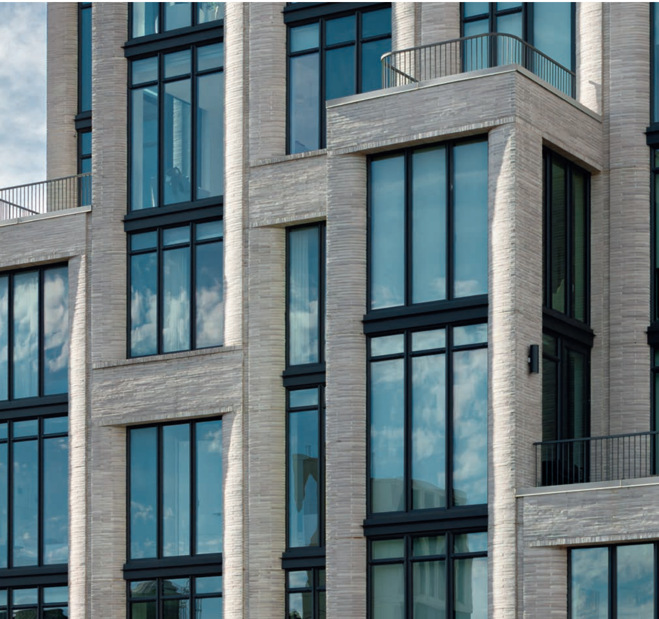
Facaden mod Broadway er udformet som en varieret komposition af murpiller og forskudte brystninger udført i lyse Kolumba. Murværkets karakter er særdeles taktil, men samtidig nærmest plastisk.
