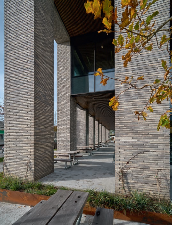
I stueetagen skaber arkader en gradvis overgang mellem ude og inde og giver plads til ophold.
