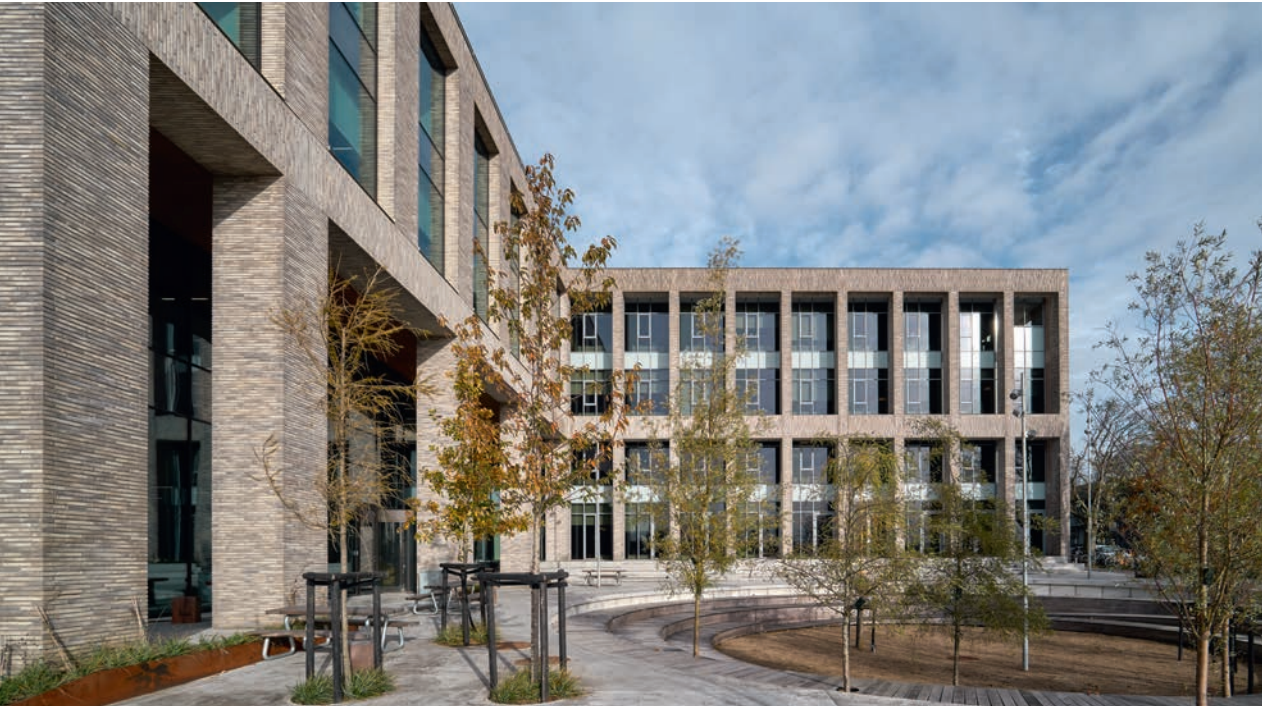
Torvet med den runde fordybning danner ramme om arrangementer for bygningens brugere. Bagerst ligger den eksisterende bygning, der er blevet iklædt et rammeværk af tegl.
