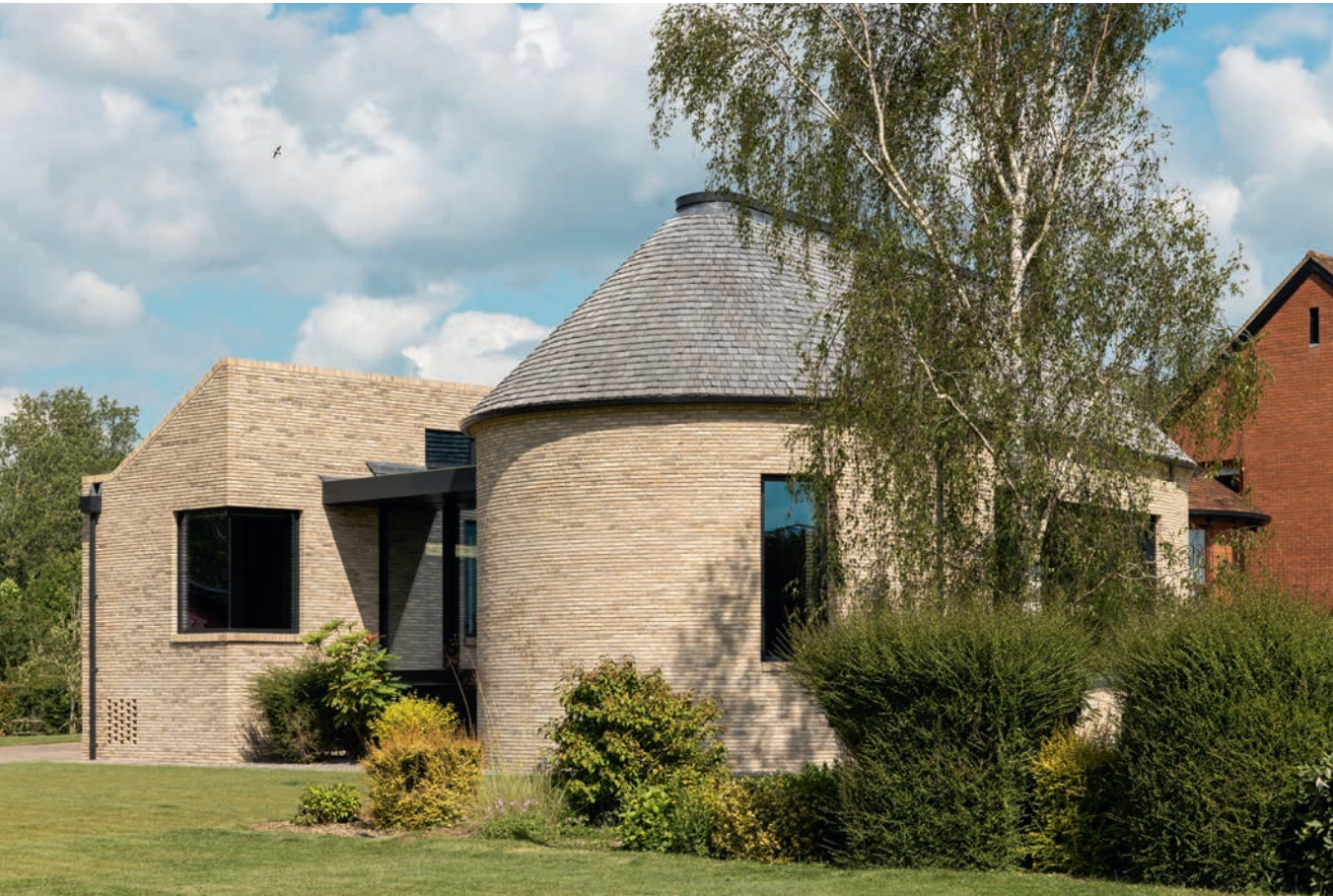
De to længer er opmuret med fuger af kalkmørtel. Taget på poolhuset er belagt med egetræsshingles.
