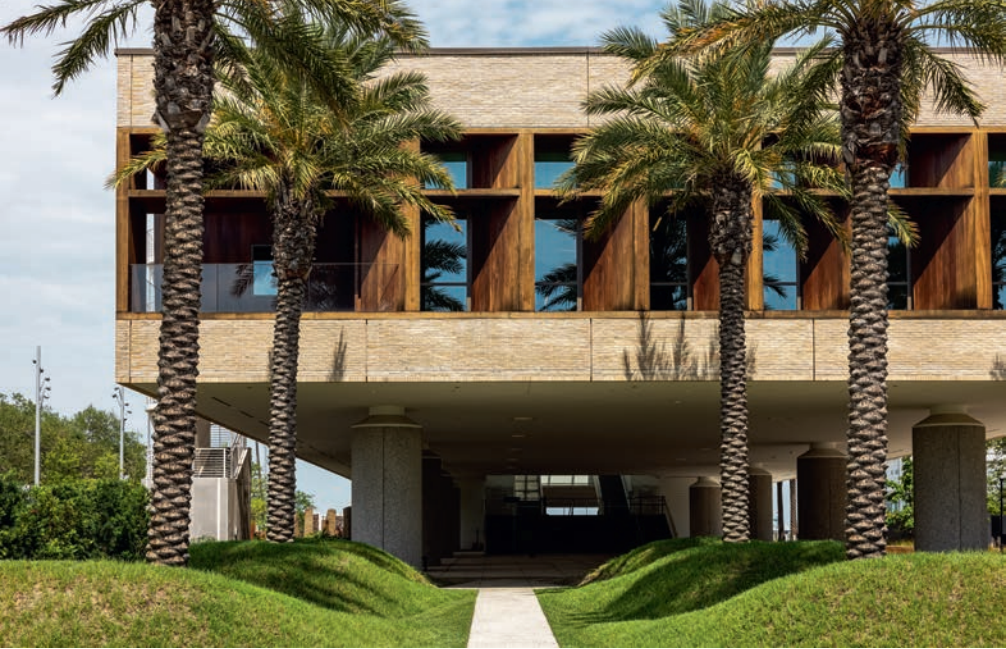
Det nye museum er beklædt med den vandstrøgne D71 i det smalle Flensborg-format, der fremhæver husets horisontale form. Gavlenes glaspartier indrammes af lameller i afrikansk sapele-træ, der leder blikket mod Atlanterhavet i øst og Charllestons centrum mod vest.
