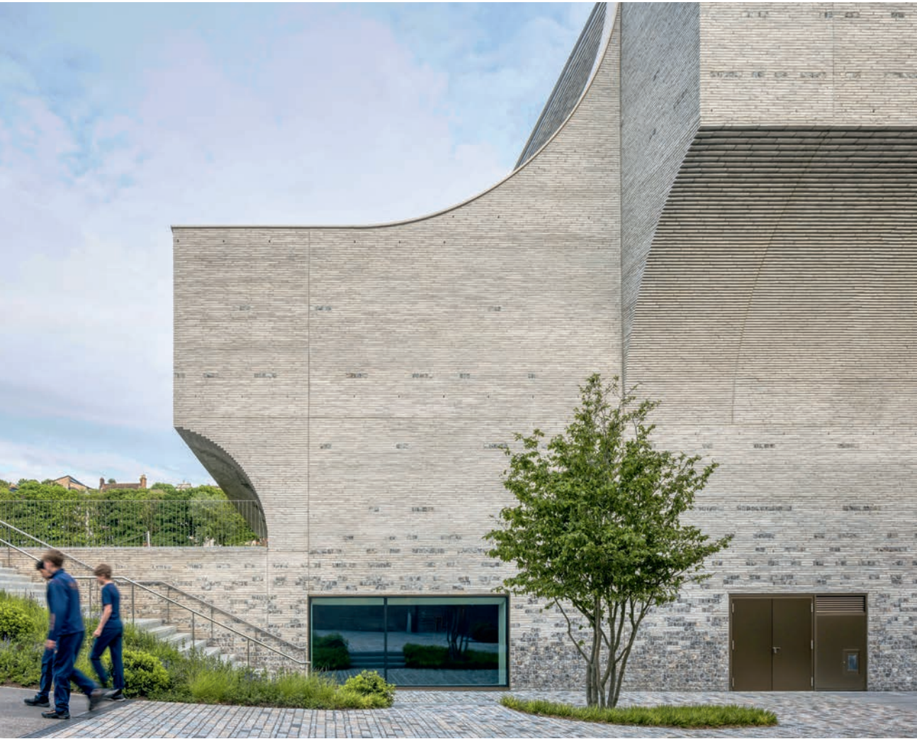
Det store vindue, der går til terræn, giver lys til det dobbelthøje dansestudie placeret i kælderen. Derved er der visuel forbindelse til gadeniveauet, uden at danserne blive forstyrret.
