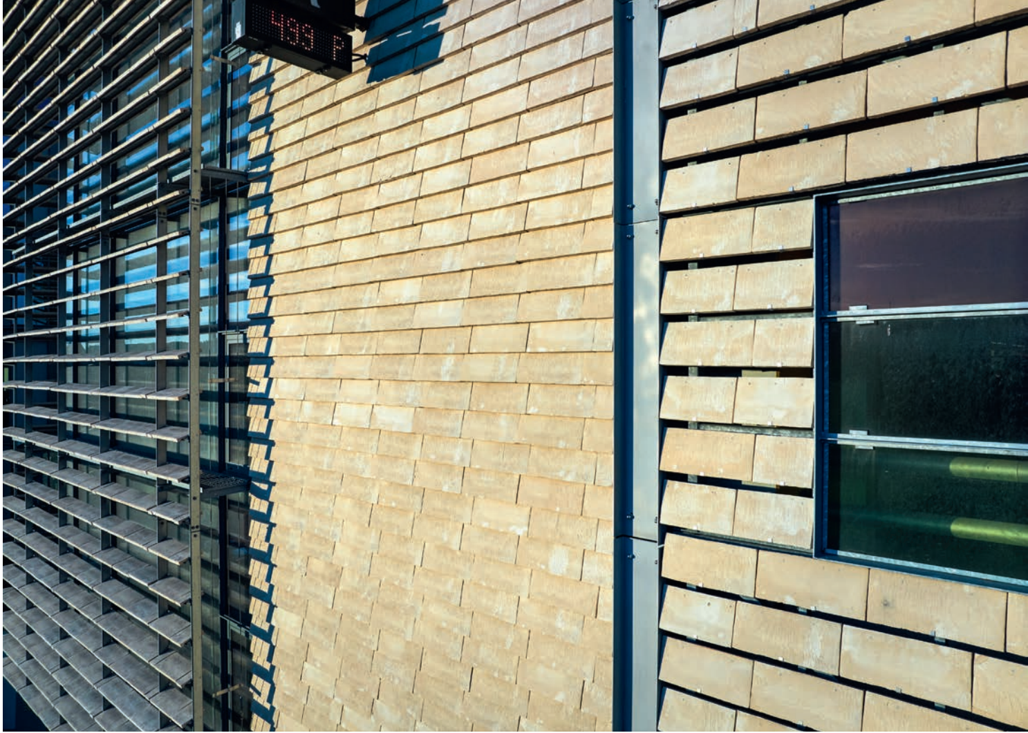
I p-huset i Jönköping er Cover anvendt henholdsvis som solafskærmning, traditionelt fastgjort som klimaskærm og monteret med afstand, så huset ventileres.
