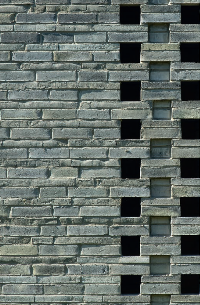
Murværket, der fremstår råt og uregelmæssigt med skifternes varierende højder og Kolumba-stenenes brud, skaber kontrast til perforeringernes systematik og præcision.
