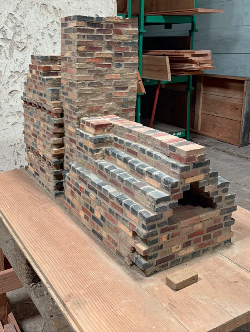
Masseovnen er bygget af juniorsten, der måler 76 x 36 x 18 mm, som er 1/3 af dansk normalformat.
