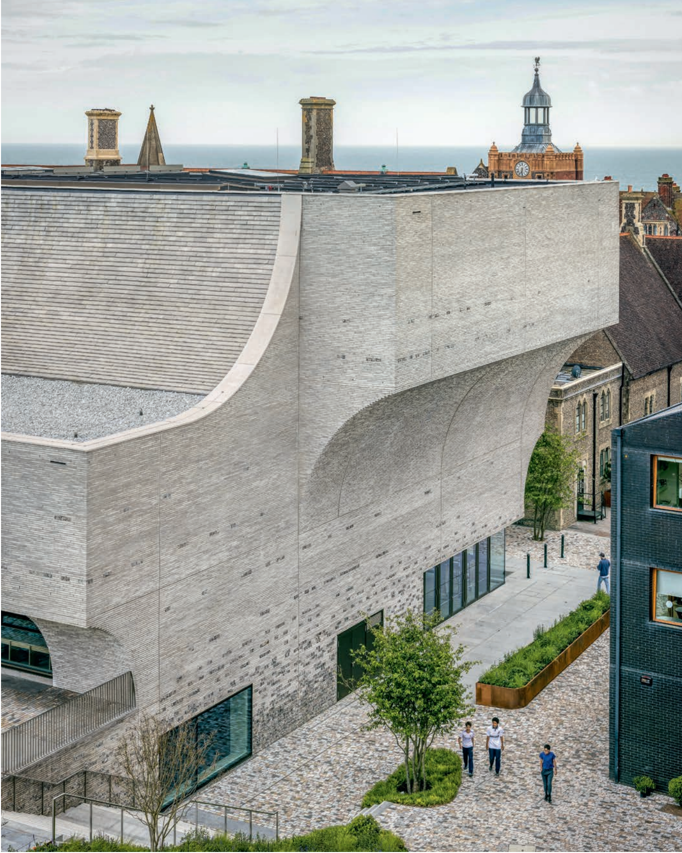
Brighton College ligger blot et par hundrede meter fra havet. Mursten er et velegnet facademateriale i det hårde kystklima, hvor salt, vind og regn slider på bygningerne.
