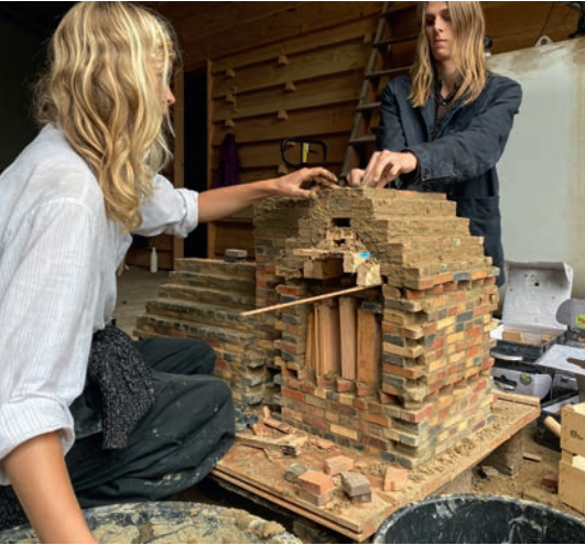
Masseovnen er bygget af juniorsten, der måler 76 x 36 x 18 mm, som er 1/3 af dansk normalformat.
