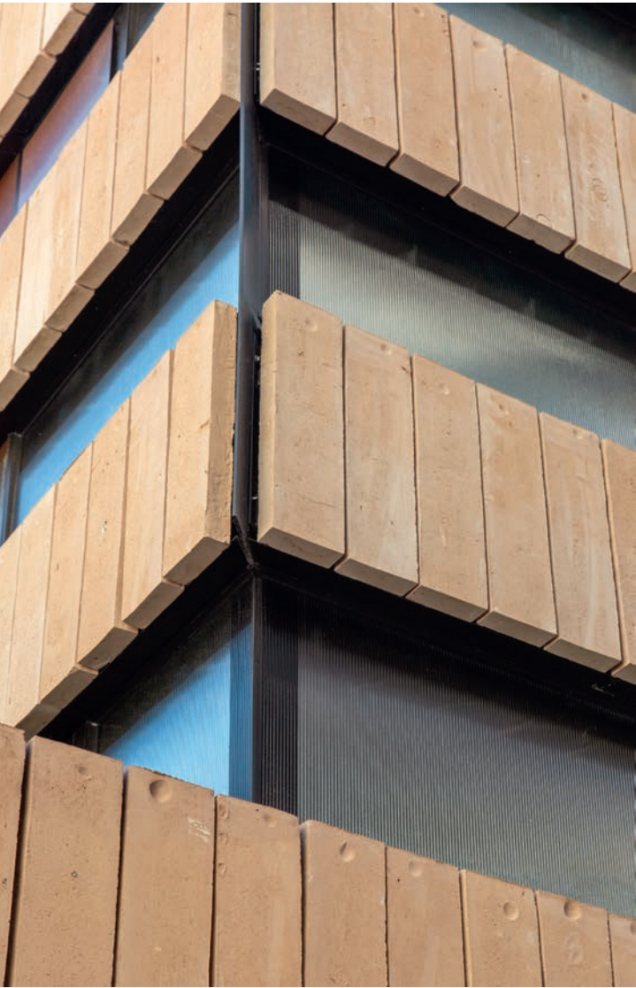
Kolumba-stenene er monteret på en stålkonstruktion, der er fæstnet til bygningens betonkerne. Aftrykkene af tommelfingre fra stenenes tilvirkning i hånden fremstår som små ornamenter.
