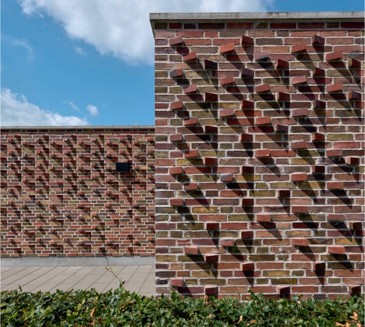
Arkitekterne blandede sten til den lange facade inspireret af Fjordenhus. Murværkets udformning skaber dynamik mellem matte og glaserede flader, fremskudte sten og huller. Udtrykket ændrer sig med vejrets og sollysets skift.
