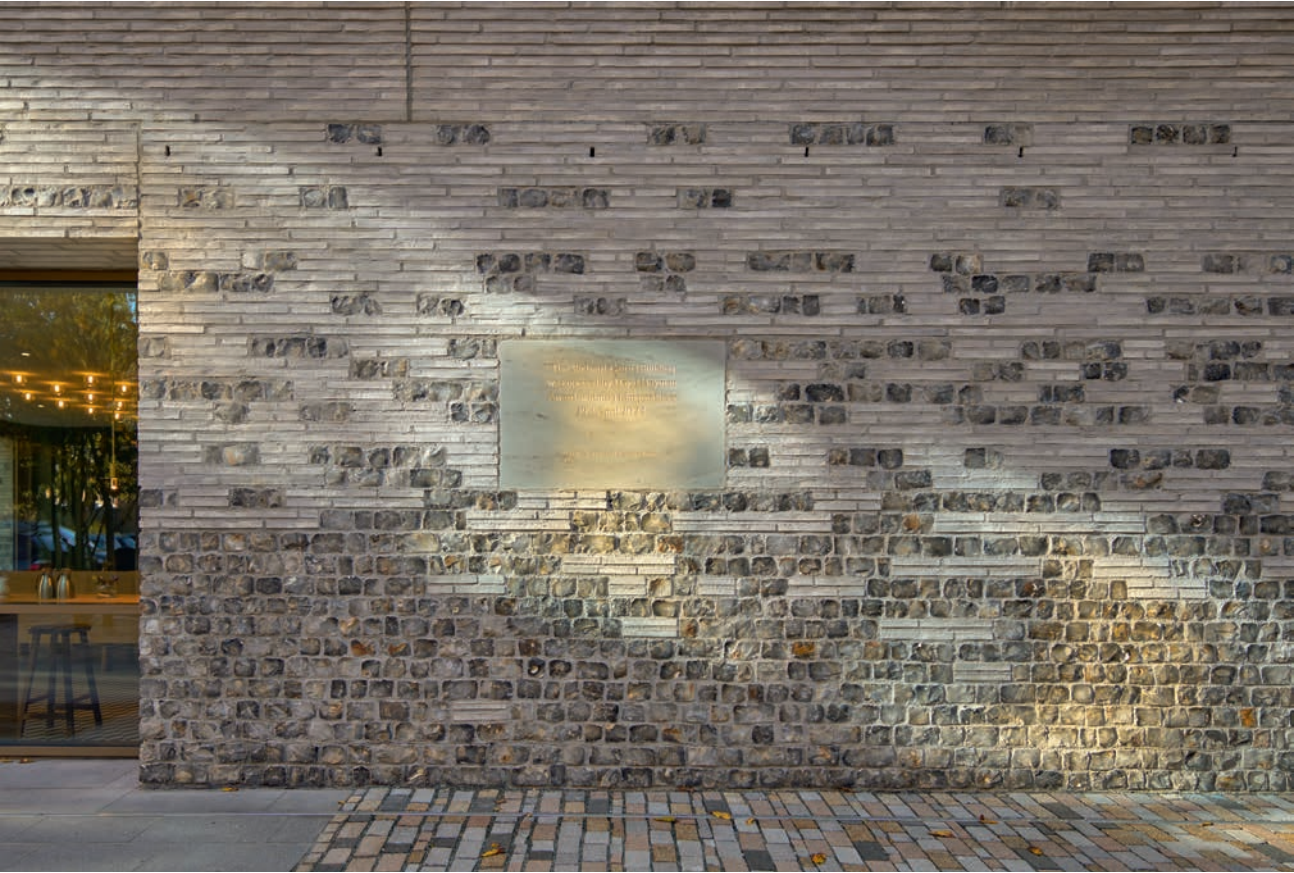
Murværket er iblandet flintesten, der opadtil gradueres. Flintens mange farvenuancer spiller sammen med Kolumba-stenens sarte nuancer. Foto: Edmund Sumner
