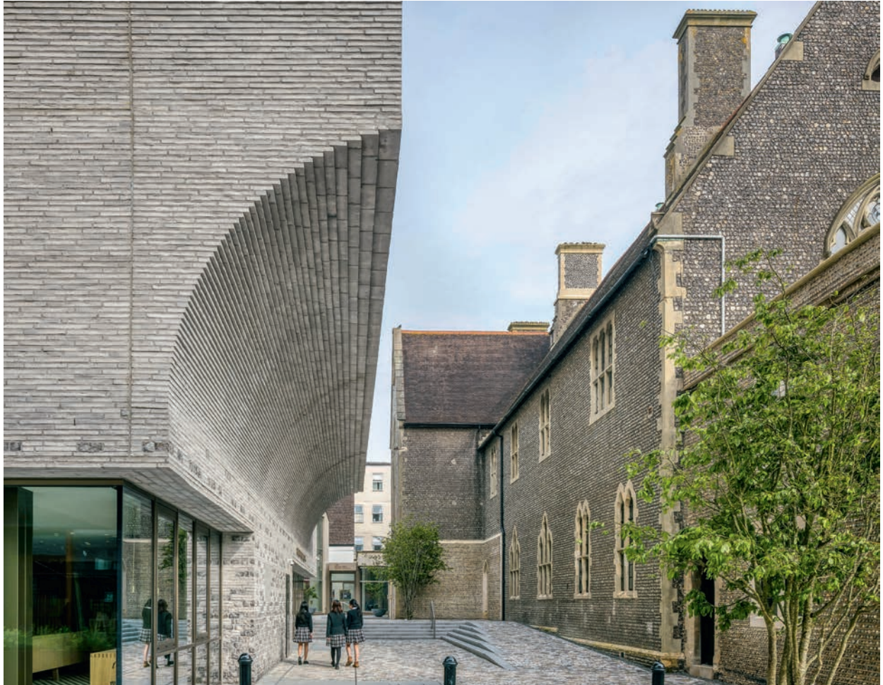
Stueetagens udkragede bue er konstrueret i løbende skifter af Kolumba, hvor hver sten er rykket ganske lidt i forhold til den foregående. Foto: Annette Petersen
