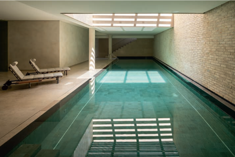
Væggene omkring husets svømmebassin i kælderetagen er beklædt med D71 DNF.
