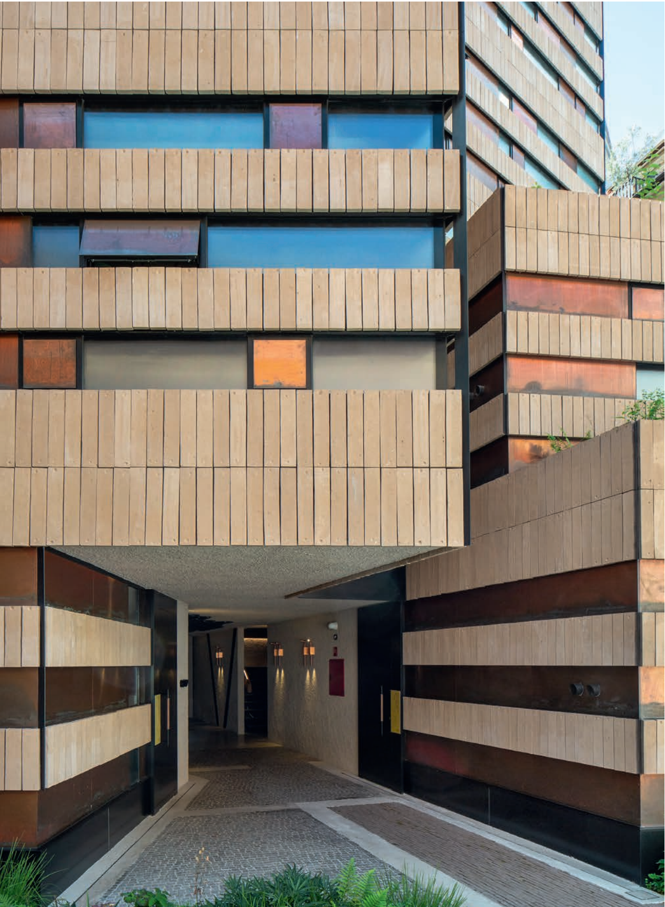
Kolumba-stenene er monteret på en stålkonstruktion, der er fæstnet til bygningens betonkerne. Aftrykkene af tommelfingre fra stenenes tilvirkning i hånden fremstår som små ornamenter.
