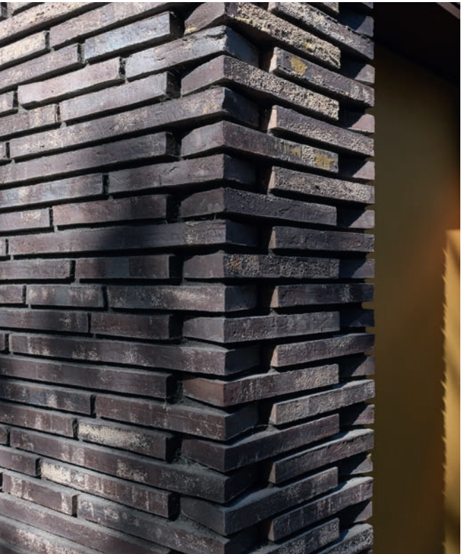
Fletmurværk danner afslutning på flere af bygningens mure.
