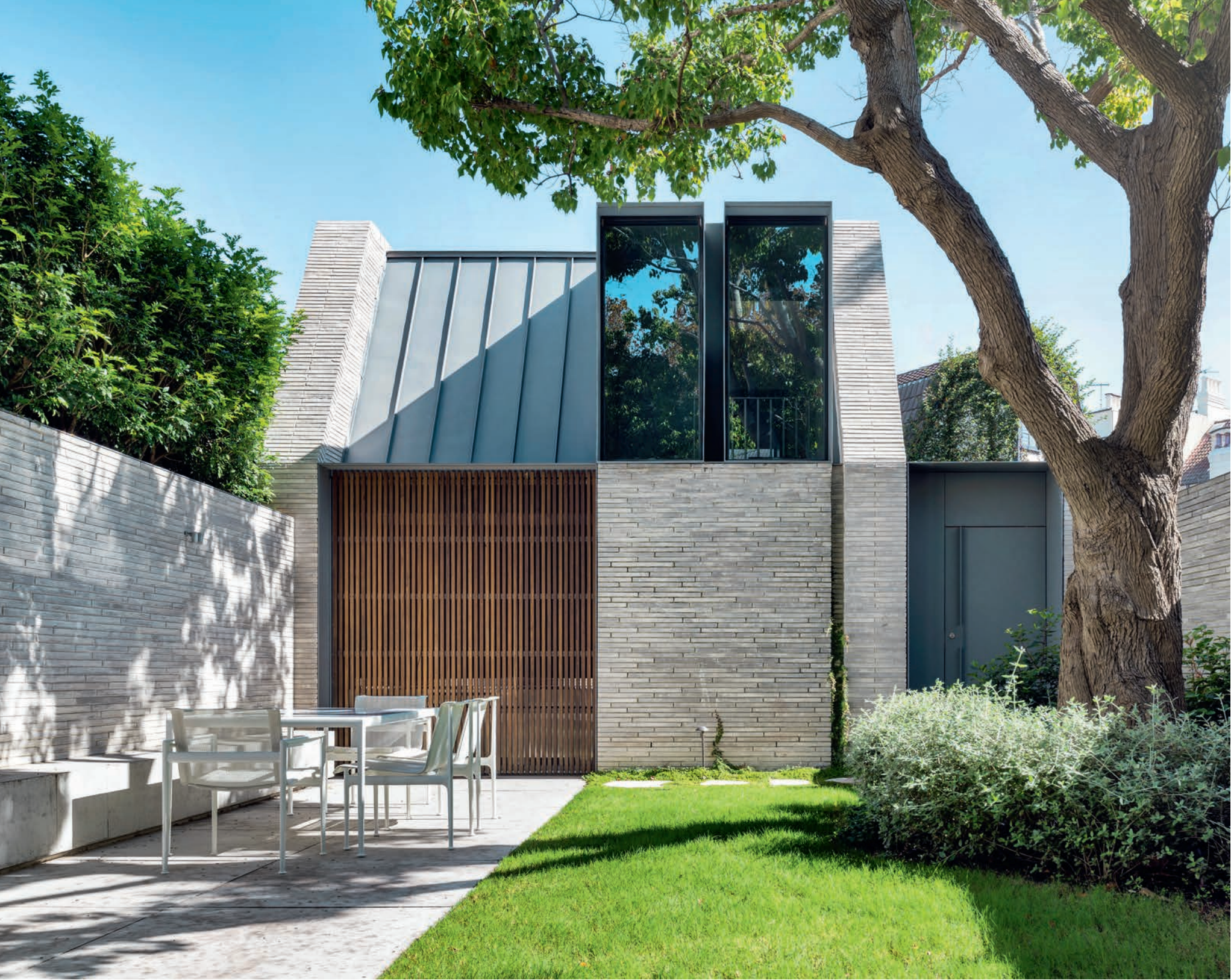
Den mindre bygning i gårdhavens modsatte ende er indrammet af store vanger beklædt med Kolumba. Facaden og havemure er i Kolumba i vildt forbandt og lameller i eucalyptus.
