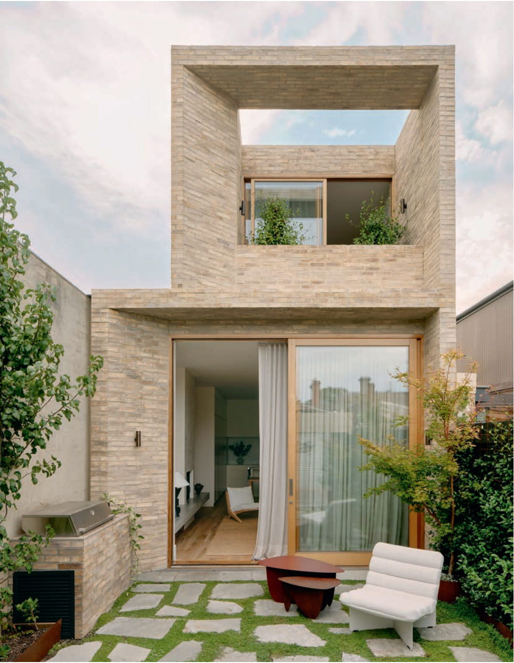
I et indbydende arkitektonisk greb er både stueetage og første sal mod øst indrammet i murede kuber, hvor den ene side er affaset. Der er anvendt et halvtstensforbandt i det lysegule murværk.
