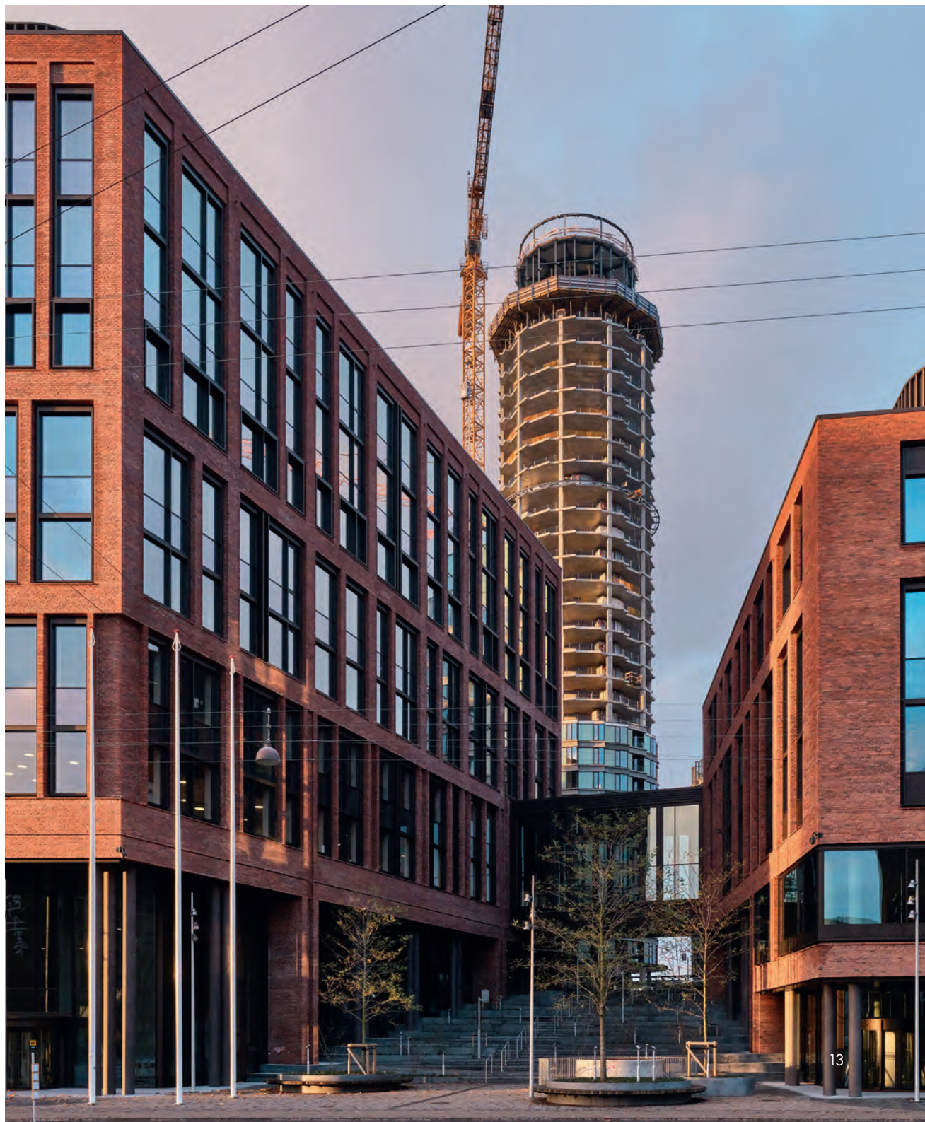
Mellem de to bygninger mod Bernstorffsgade er der skabt et kileformet, offentligt rum, hvor et trappeanlæg inviterer fodgængere op til et plateau og videre rundt til en plads, der senere i år vil blive indrettet med planter, bænke og borde. De bagvedliggende tårne med lejligheder vil stå færdige i år.
