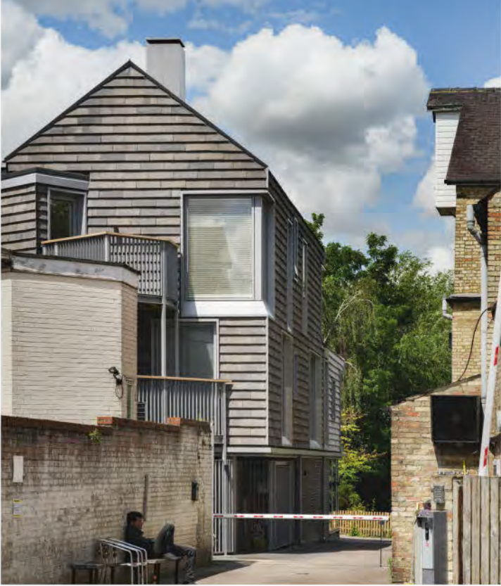
Foruden stenens æstetiske kvaliteter spillede det en væsentlig rolle for arkitekter og bygherre, at Cover kan afmonteres og genbruges, nærmest uendeligt.
