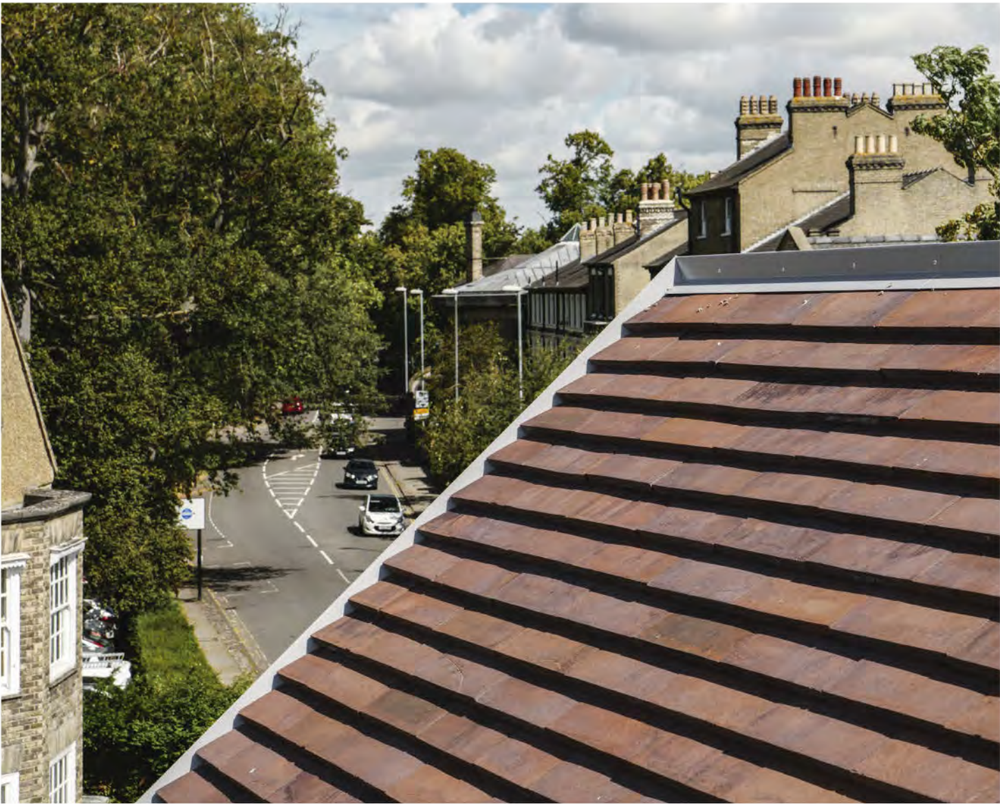
Mødet mellem henholdsvis tagets Coverbeklædning og gavl og de Coverbeklædte facaders møde om et hjørne kan detaljeres på en række forskellige måder. MCW Architects valgte i begge tilfælde at lade Coverstenene løbe vinkelret ind på et aluminiumsprofil. agets kip afsluttes ligeledes med en aluminiumsinddækning.
