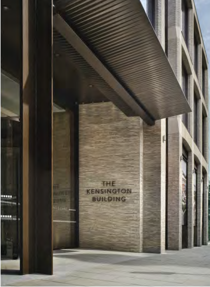
Lofthøjden på 5,6 meter mod gaden skaber en følelse af åbenhed. De dybe vinduespartier fremhæver de murbeklædte søjler og skaber skyggevirkning i facaden.
