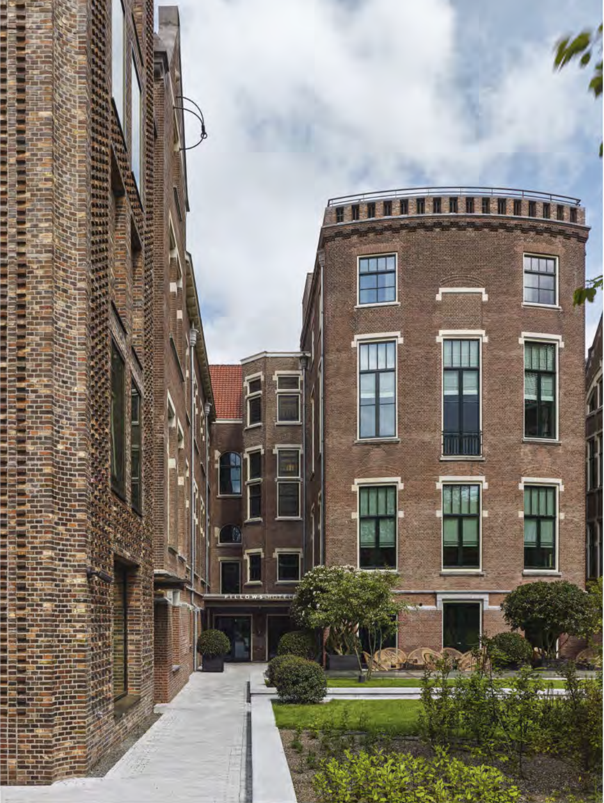
Restaurering og transformation af den tidligere universitetsbygning er gennemført med stor nænsomhed og vilje til at bevare så mange originale rum og detaljer som muligt.
