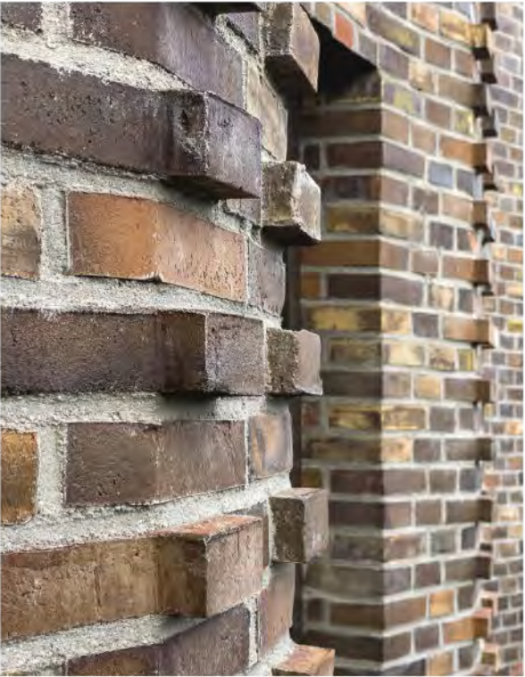
Office Win ov tegnede i alt 12 forskellige formsten til den nye bygning, der hovedsageligt er anvendt i husets krone, hjørner og omkring dørpartier. Murværkets basissten er ligeledes fremstillet i en specialstørrelse, 210 x 100 x 50 mm, der er stenformatet i universitetsbygningen fra 1908.
