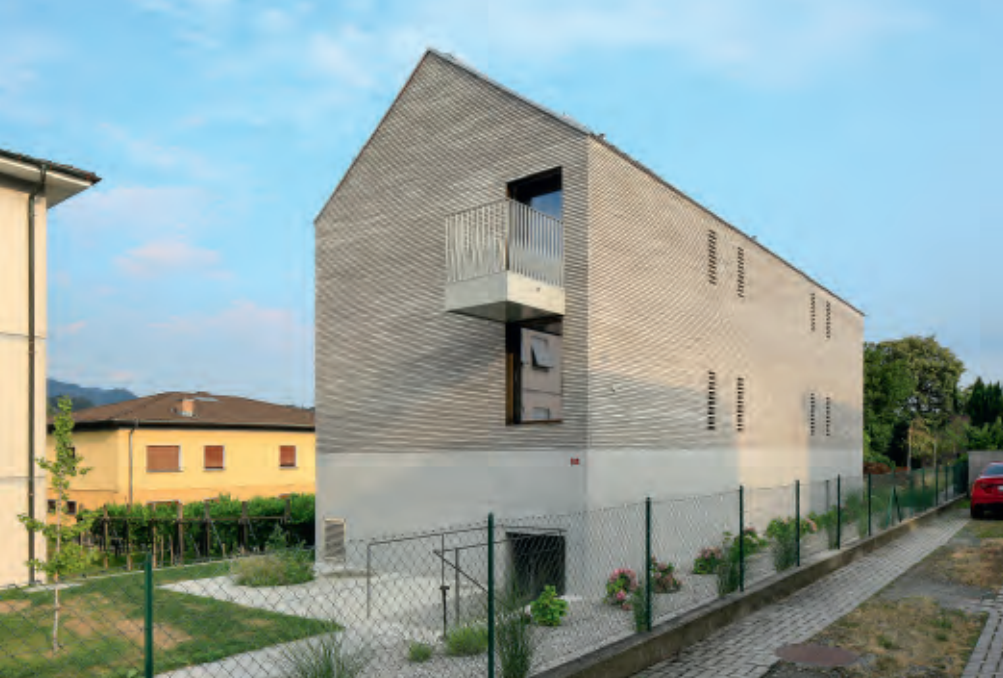
Langs den vestvendte facade løber havestien til Atelieret. For at undgå indbliksgener er vinduer erstattet med fletmurværk, der lukker lys ind til de bagvedliggende, sekundære rum i boligerne.
