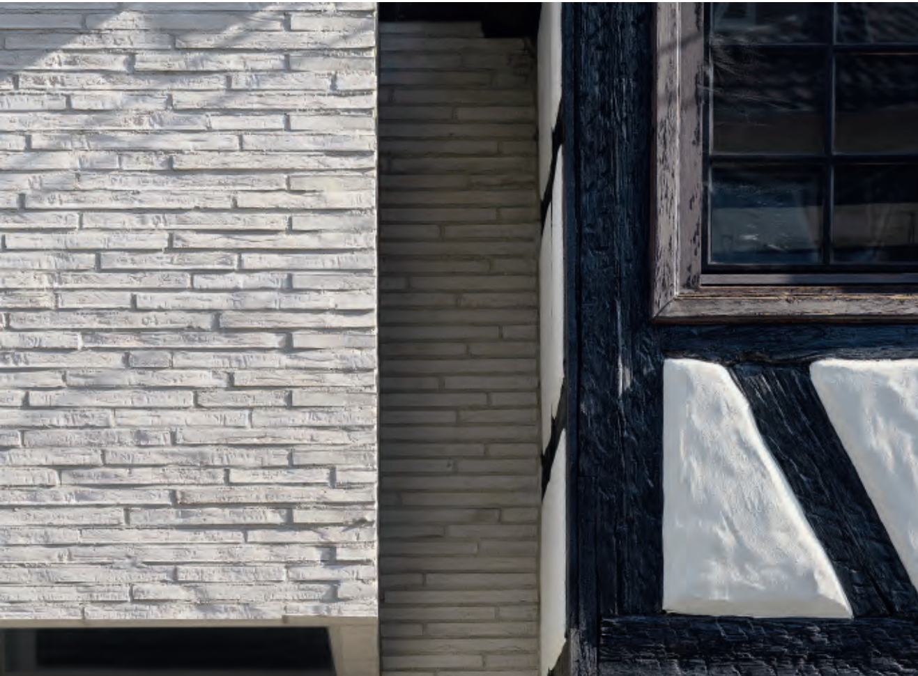
Den nye tilbygning er tydeligt differentieret i forhold til det mere end 300 år ældre nabohus, idet facadens mursten er eksponerede i stedet for pudsede. Samtidig er der fælles træk mellem de to i form af materialernes lyse nuancer og den strukturerede overflade i henholdsvis bindingsværkets tavl og de håndstrøgne mursten.
