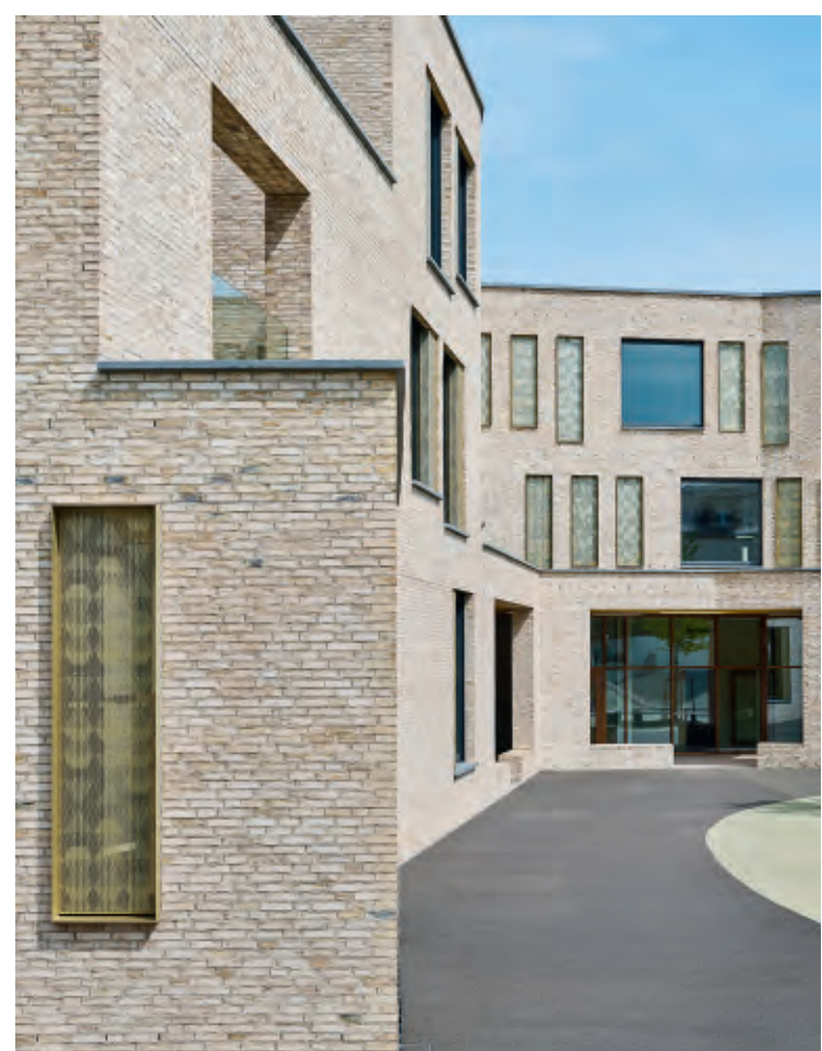
Bygningens lyse sten relaterer til de lyse nabobygninger. Den grå fuger er plan med stenene for at skabe en sammenhængende flade.
