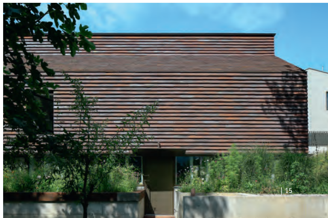
Underfacadens glasbånd ligger i let tilbagetrukket reces fra den overliggende teglmonolits massiv, som derved står sitrende i luften ovenover den grønne staudesky.
