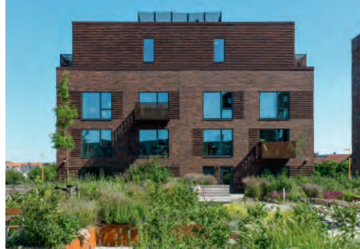
Samtlige punkthuse råder over en tagterrasse forbeholdt husets beboere. Derudover har alle beboere adgang til den 4.000 m 2 store, fælles taghave i førstesalshøjde.
