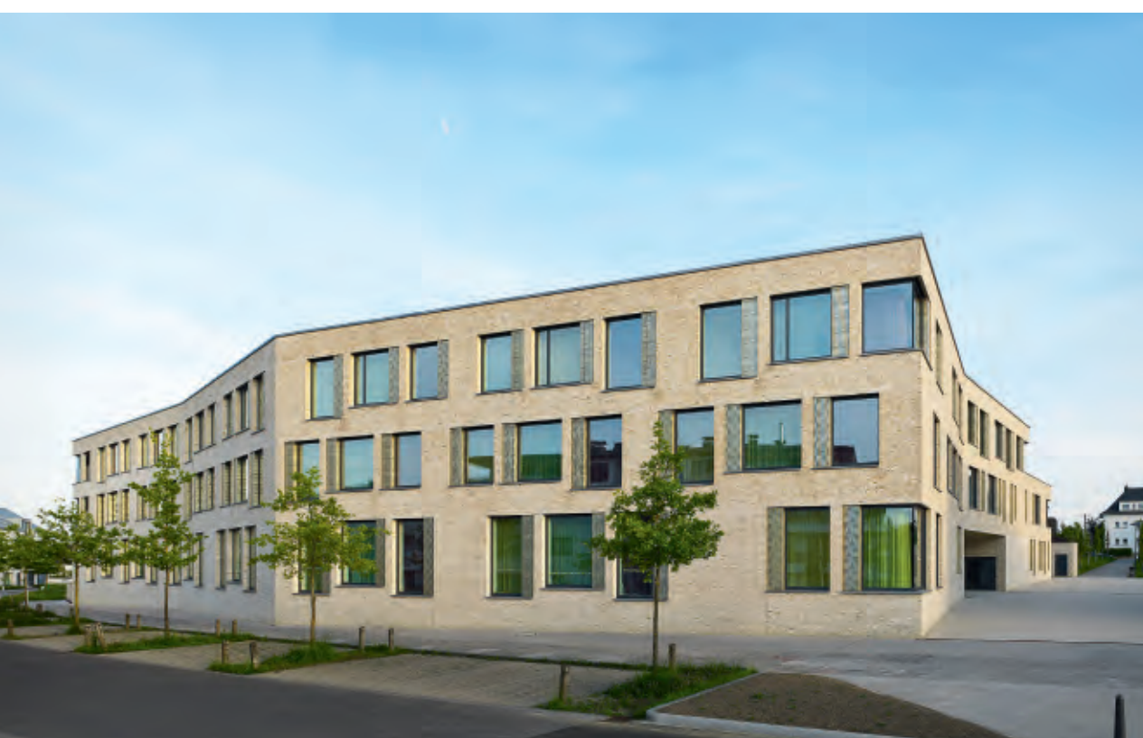
Skolens L-formede volumen er tilføjet knæk, der sammen med skiftende bygningshøjder og en pergola giver variation og sørger for tilpasning til omgivelsernes skala.
