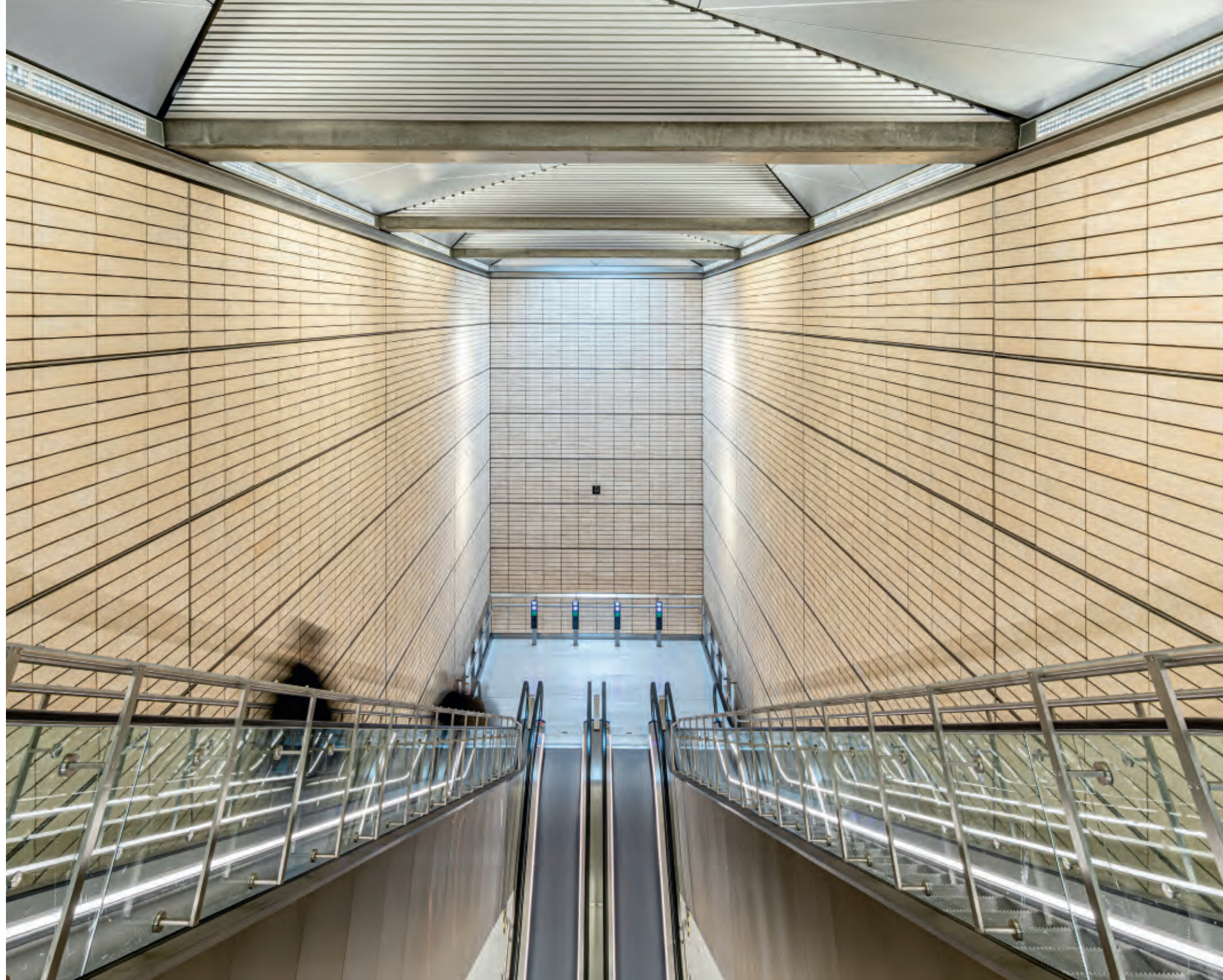
Storbymonumentet Cityringen, der åbnede den 29. september 2019, betegnes som det største danske anlægsprojekt i 400 år. Metroen har siden åbningen modtaget flere internationale designpriser inkl. Bronze i The Architecture MasterPrize 2020.
