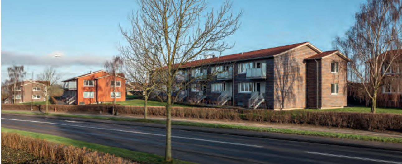
Ringbakken består af fire lave boligblokke omgivet af et grønt fællesareal. Facaderenoveringen har givet bebyggelsen et nutidigt og langt mere kvalitetspræget udtryk.
