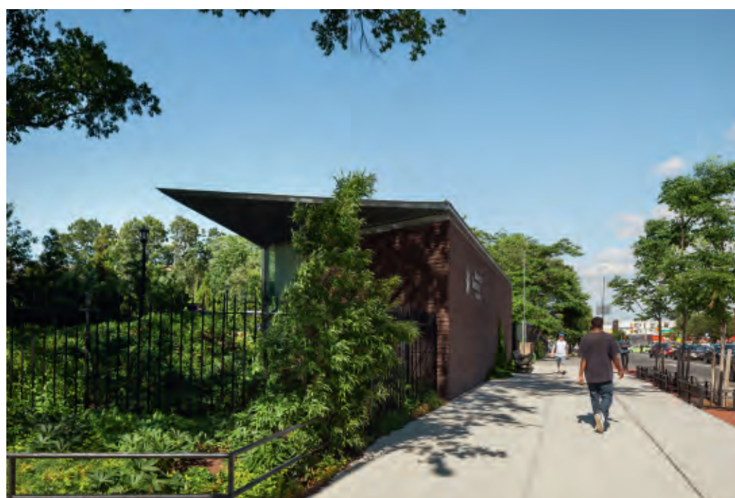
Pavillonen, der danner ryg mod den trafikerede Empire Boulevard, er udformet med et stort, ensidigt hældende tag beklædt med zink. Foto: Elizabeth Felicella
