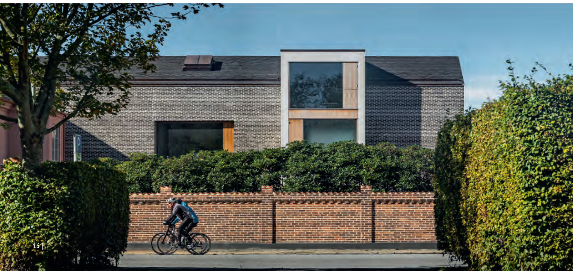
Tilbygningen er udformet som en moderne fortolkning af Skånes klassiske langhus. Facadernes mørkegrå murværk er i fin samklang både med hovedhusets pudsede facade i rosa og rødstensmuren mod gaden.
