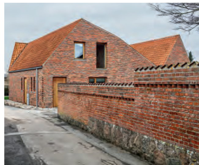
Til det fuldmurede sognehus valgte arkitekter og bygherre en kulbrændt sten, hvis nuancer i rød, grå og brun genfindes i kirke og kirkegårdsmur.
