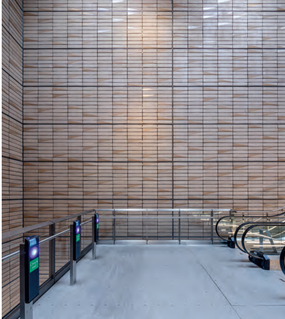
Metrostegen – en modificeret, håndlavet Kolumba – er monteret i en let stålkonstruktion, der giver plads til den omfattende, bagvedliggende kabelføring.
