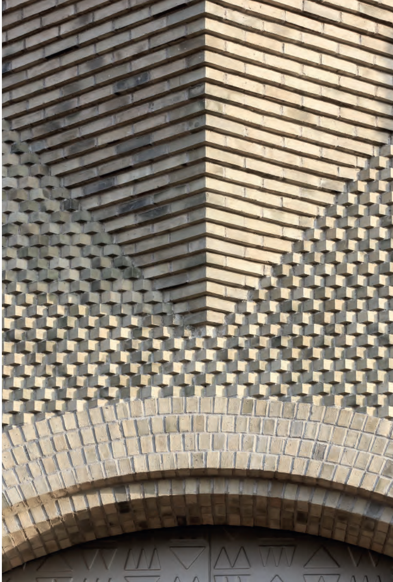
Petersen Tegl fremstillede formsten med 30 graders vinkel, således at bygningens karnapper mod Lammermarkt-pladsen kunne udformes i den samme vinkel. Stenene forekommer dermed nærmest at vokse ud af muren. Foto: Paul Kozlowski
