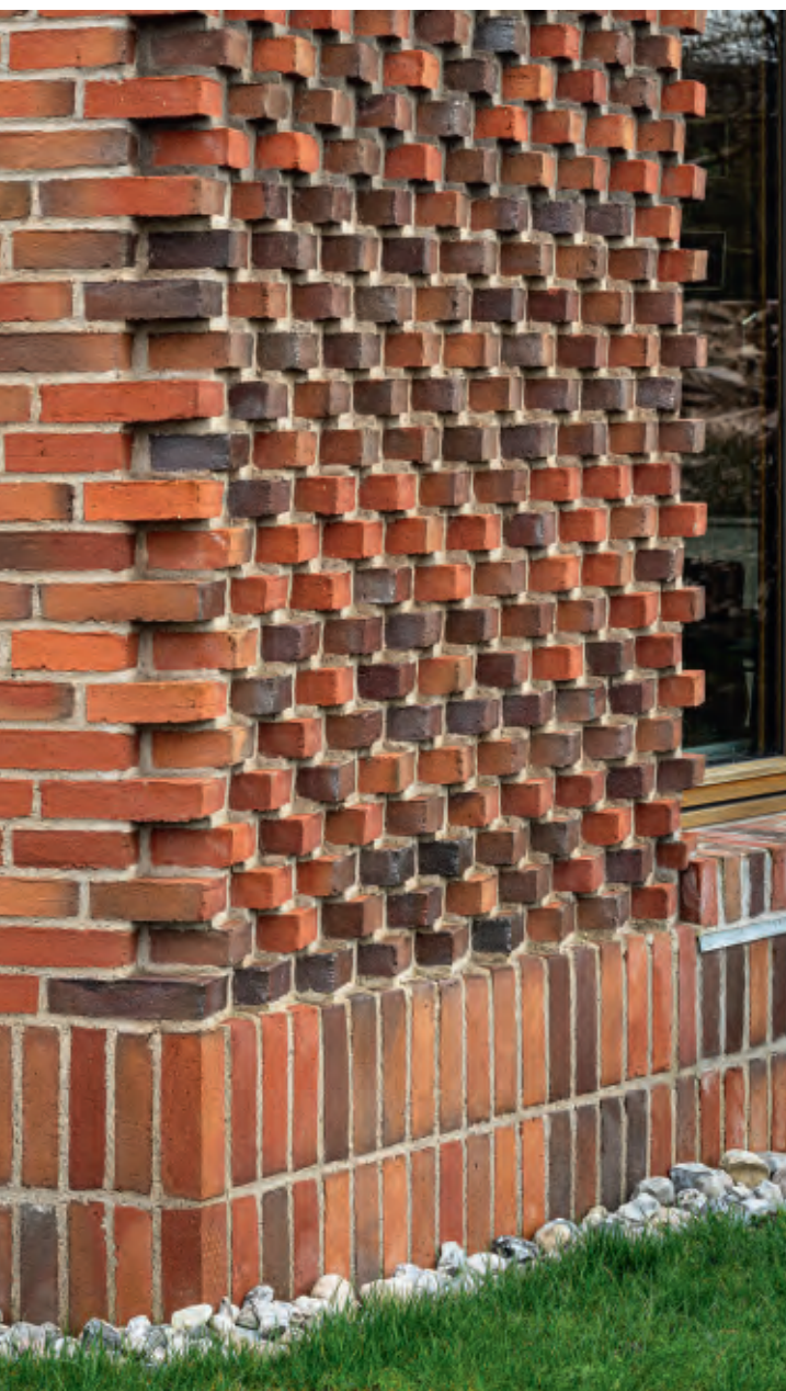
Klassiske detaljer som soklens rulskifte og det savtakkede murværk på hjørner hæver bygningens udtryk og giver samhørighed med kirkens murværk.
