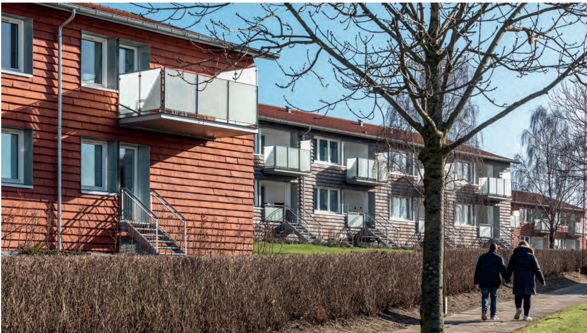
Alle førstesalslejligheder har nu altaner, mens alle stuelejligheder har fået direkte adgang til egen terrasse og fællesareal. Det opgraderede facadeudtryk og de forbedrede muligheder for udeliv har styrket det sociale fællesskab i Ringbakken.
