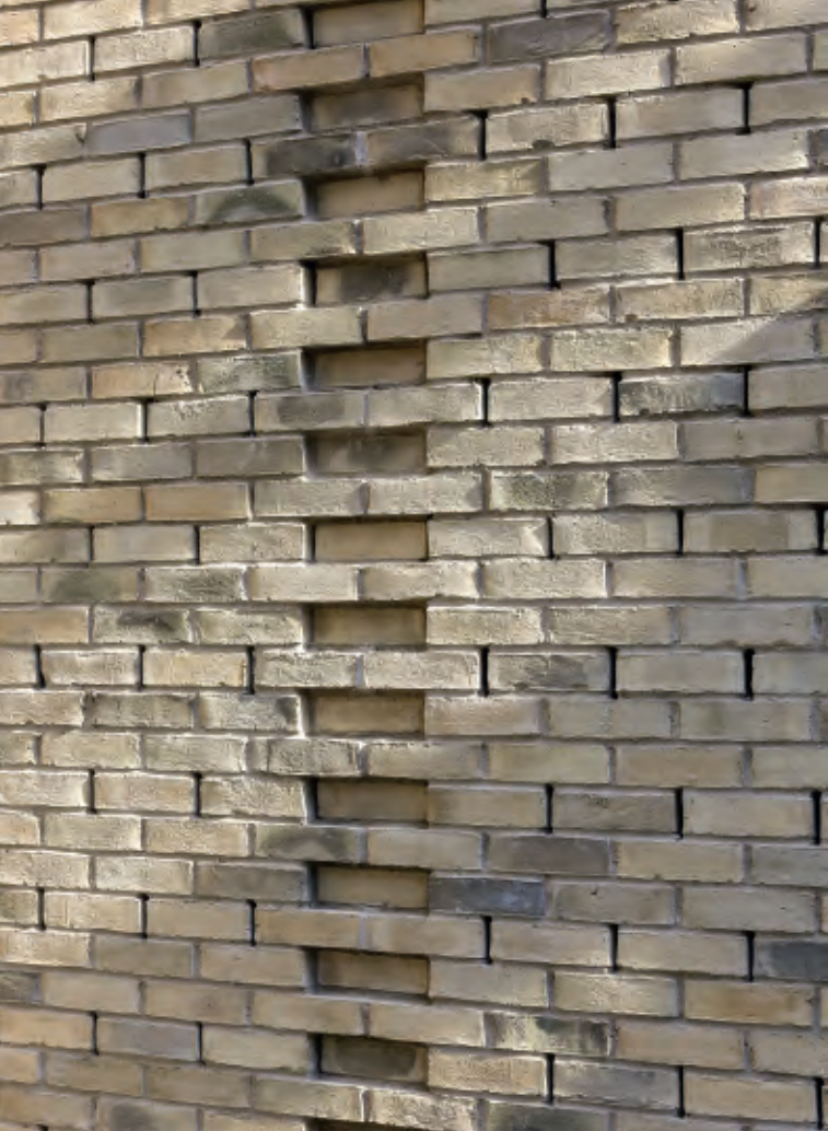
Muren, der danner facade mod den overdækkede Achterplaats, er udført med åbne fuger som del af rummets ventilationsanlæg og fungerer desuden som akustikvæg. Foto: Paul Kozlowski
