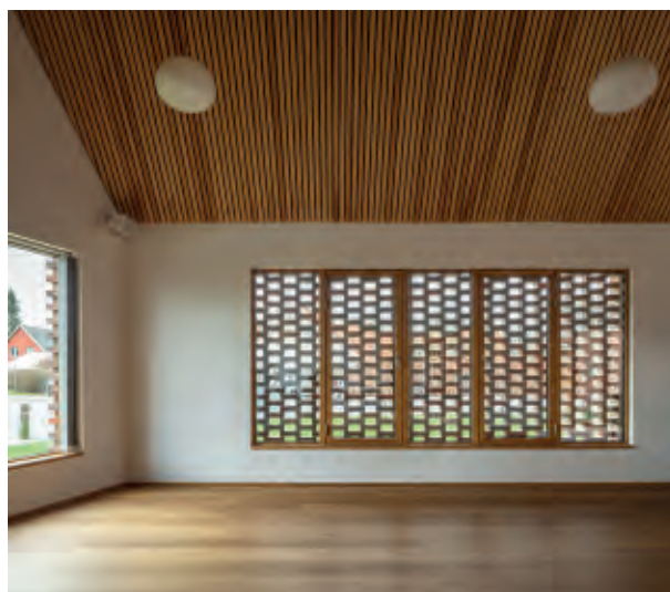
Perforeret murværk foran vinduet i husets fællesrum skærmer mod kørende bilers lygter.
